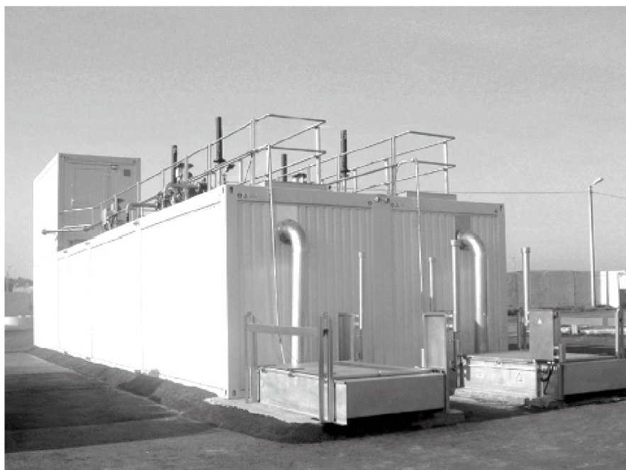
Рисунок 3 – Комплексные локальные сооружения очистки «Адмирал».
